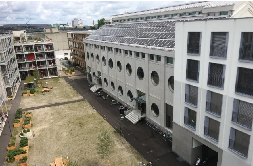
Umnutzung alter Silo, gemeinsame Aussengestaltung
